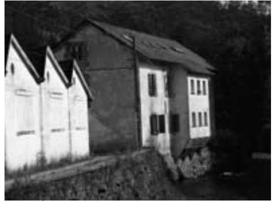
Au tissage du Pont à Lepuix-Gy, des logements collectifs sont construits dans l'enceinte de l'usine
